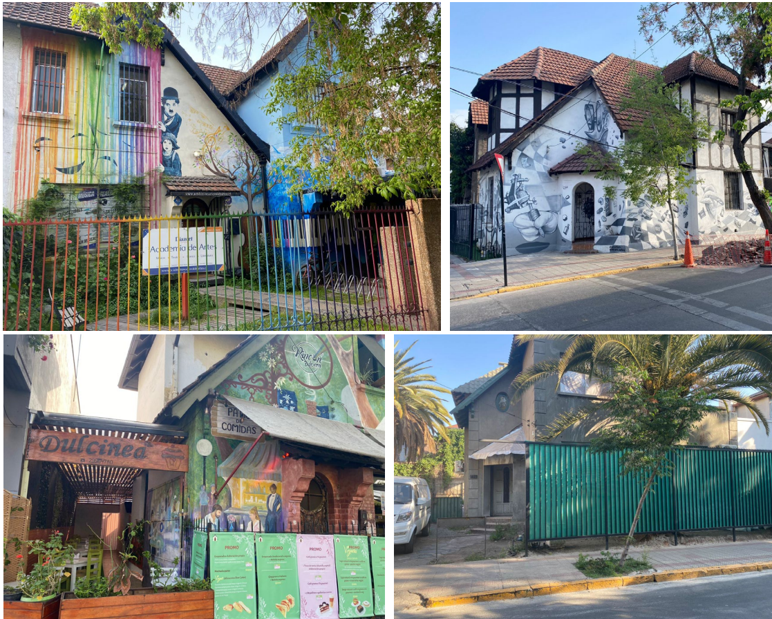
Figura 36 Fotos deterioro fachas ZCH Población Salvador Legión Militar de Chile. Fuente: Elaboración propia.
