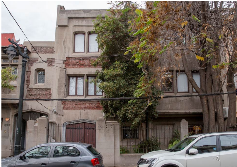
Figura 53 Elevaciones y análisis morfológico de la edificación en Triana 877. Fuente: Elaboración propia, foto de Google Earth.
