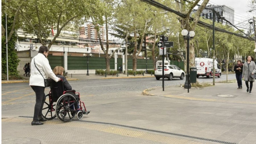
Figura 75 Ejemplo de nivelación de cruce peatonal, vereda continua en Europa con Pedro de Valdivia. Fuente: Providencia.cl.
