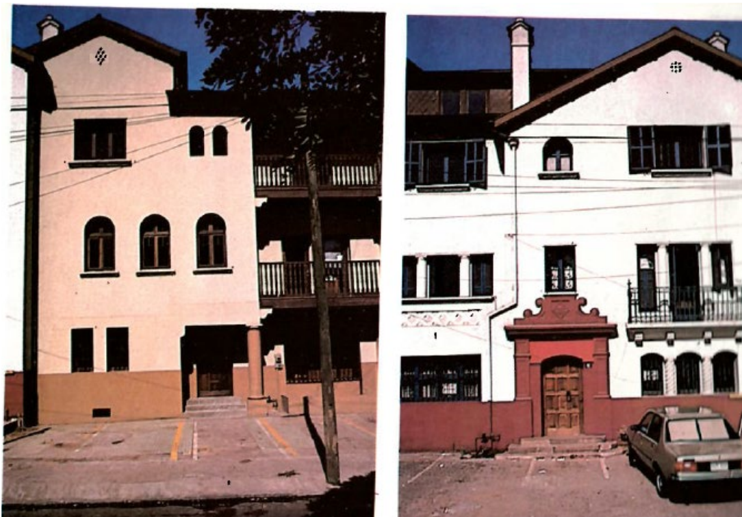
Figura 48 Fotos Elementos ZCH Conjunto calle Triana. Fuente: Boza y Duval (1982).
