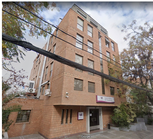
Figura 98 Edificación sin tipología y discordante. Fuente: Elaboración propia y fotografía de Google Earth.
