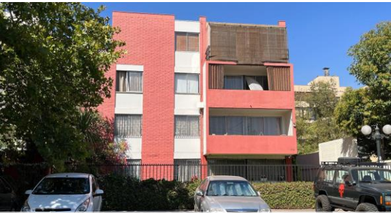
Edificio de 4 pisos aislado con antejardín
