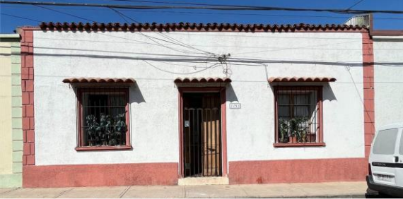
Vivienda fachada continua de un piso sin antejardín
